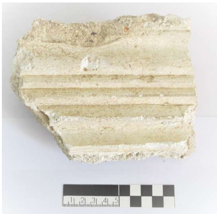
Figura 7. Fragmento de la cornisa moldurada de estuco de la cata A.
